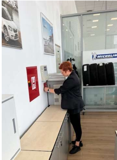
Slika 33. Ispitivanje ručnog javljača
