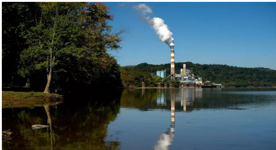
Slika 11. Primjer industrijskog postrojenja koje ispušta zagrijanu vodu [39]
