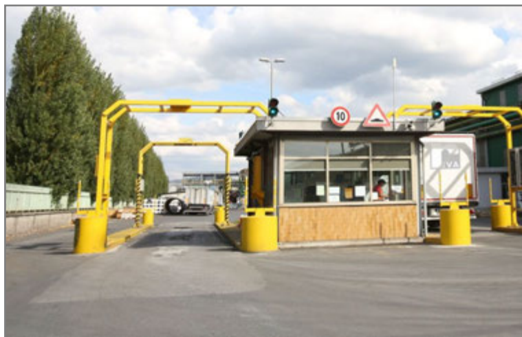
Slika 2. Primjer instaliranog stacionarnog sustava/portala na ulazu u proizvodni pogon gdje se obrađuje čelični otpad [37]
