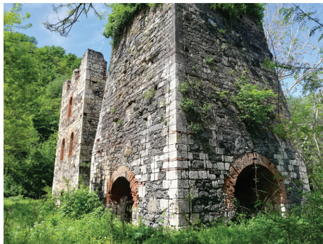
Visoke peći Bešlinec
