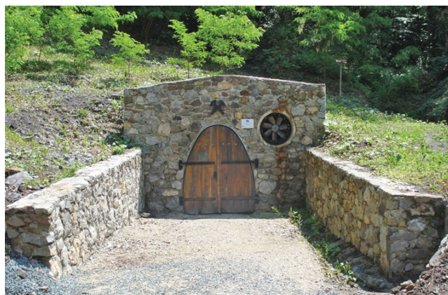
Portal potkopa sv. Trojstva stare jame željezne rude sv. Barbare, Rude
