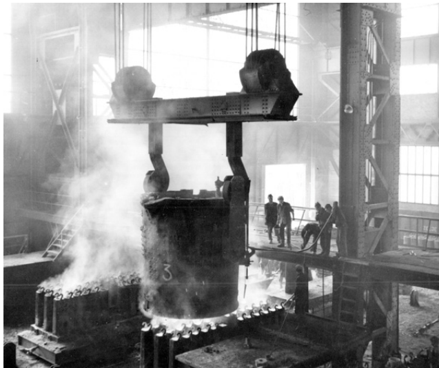
Lijevanje čelika iz velikog lonca u kalupe, Željezara Sisak, druga polovica XX. st.
