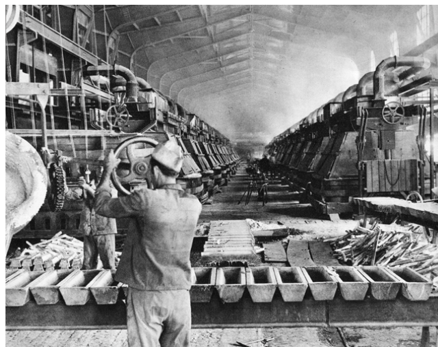
Hala s ćelijama za elektrolizu u Tvornici aluminija Lozovac, 1960-ih
