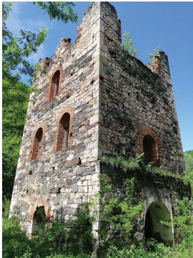
Visoke peći Bešlinec
