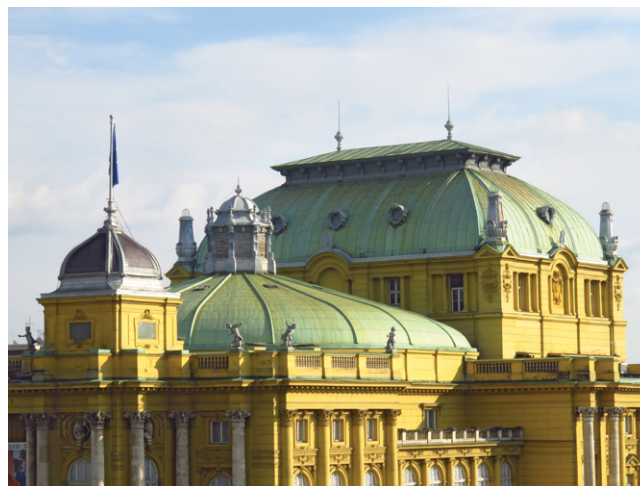
Primjena bakra za krovni pokrov, Hrvatskog narodnog kazališta, Zagreb
