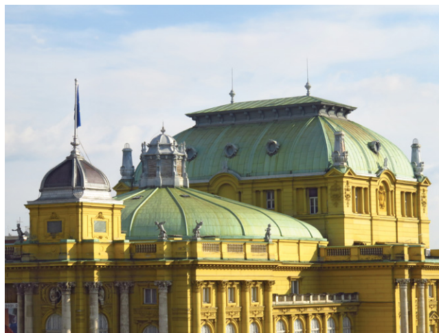
Primjena bakra za krovni pokrov, Hrvatskog narodnog kazališta, Zagreb
