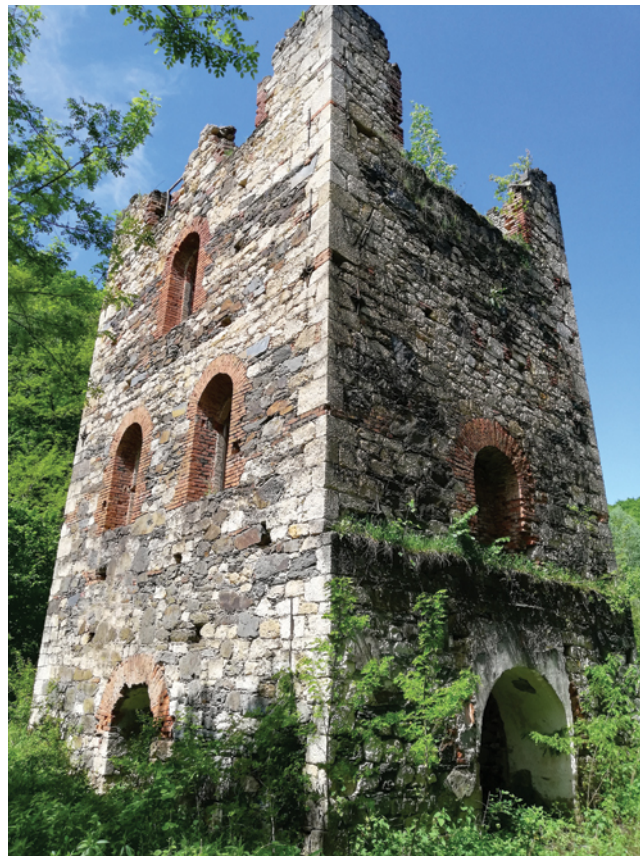
Visoke peći Bešlinec
