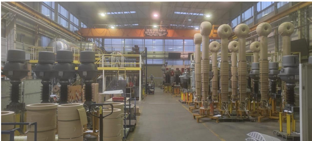
Slika 6: Prostor montaže za rad
