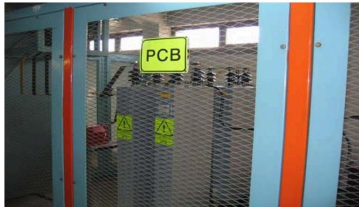
Slika 3. Označavanje električnog transformatora koji sadrži PCB [18].
