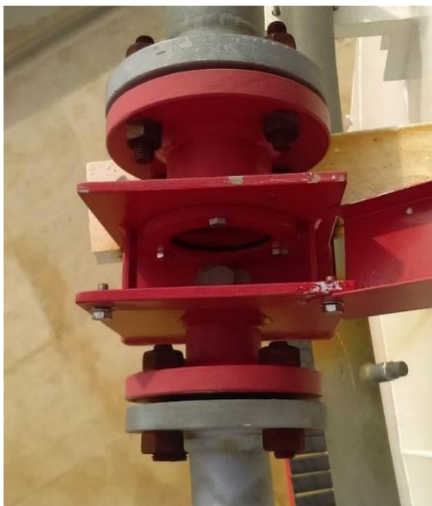
Slika 17. Prikaz jedne vrste zračnih komora za čvrste spremnike
