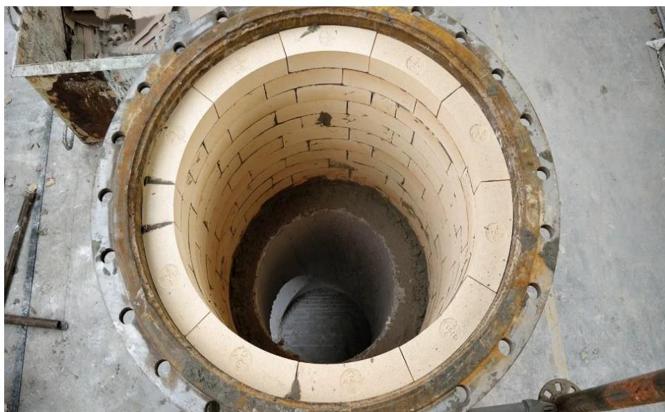
Slika 7. Primjer ozida peći [13]
