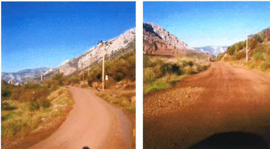
Slika 12. Cesta izgrađena od crvenog mulja [46]
