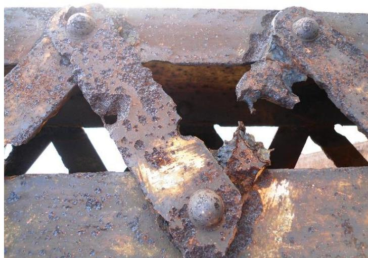
Slika 11. Primjer pjegaste korozije poprečnog nosača mosta [14]
