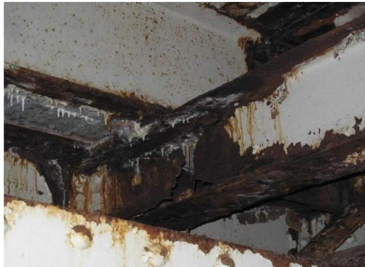
Slika 14. Korozija u procijepu čelične konstrukcije mosta [18]
