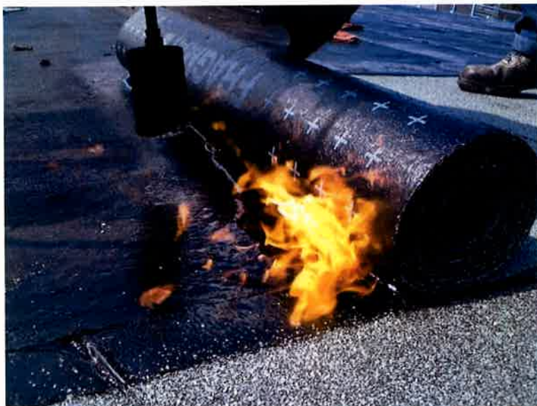
Slika 18. Ugradnja bitumenskih traka [30]
