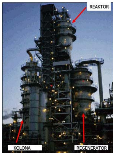
Slika 10. Jedinica za proces katalitičkog kreiranja u fluidiziranom sloju, FCC [26]
