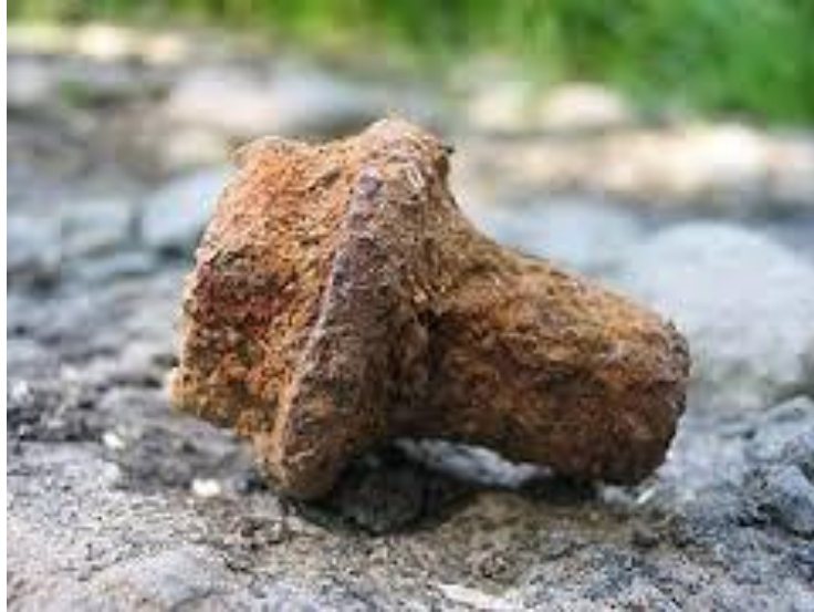
Slika 4. Praktični primjer elektrokemijske korozije čelika [12]
