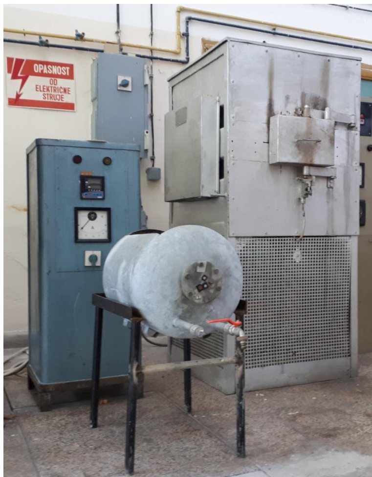
Slika 30. Fotografija elektrootporne komorne peći za žarenje
