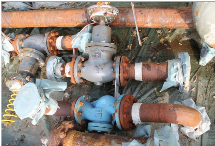
Slika 4. Dijelovi cjevovoda geotermalne vode s naslagama prirodnih radionuklida pronađen u čeličnom otpadu [29]
