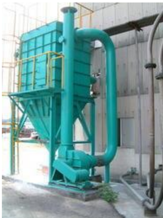
Slika 13. Fotografija industrijskog vrećastog filtra [14]
