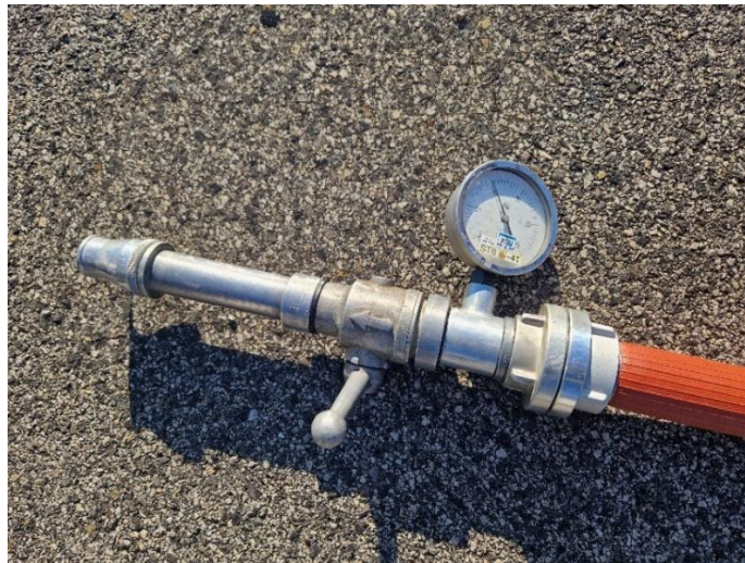
Slika 47. Provjera tlaka tijekom ispitivanja
