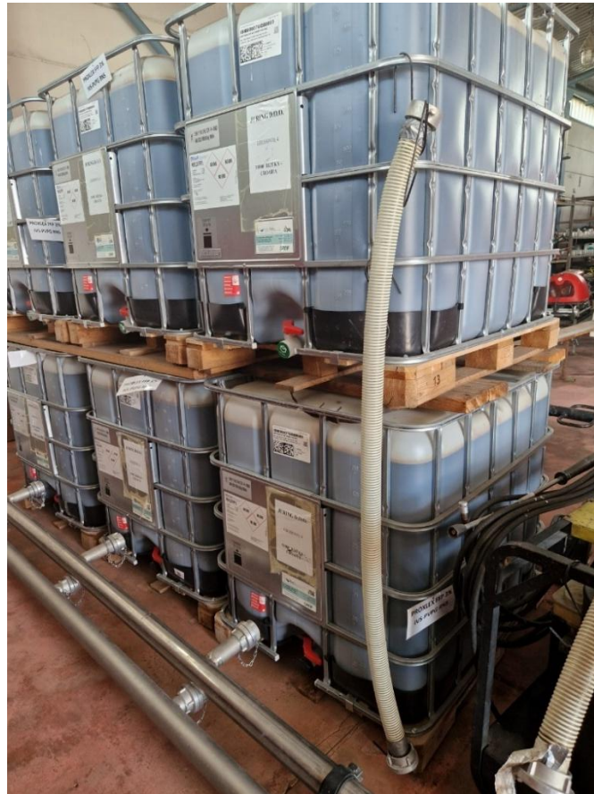
Slika 6. Plastična usisna cijev za pretakanje pjenila ili rad s međumješalicom
