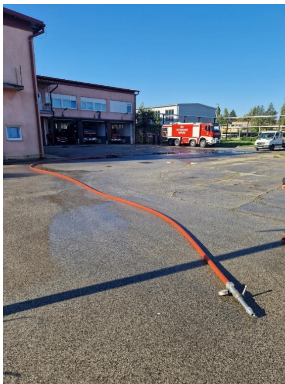
Slika 46. Postavljanje ispitne cijevne pruge
