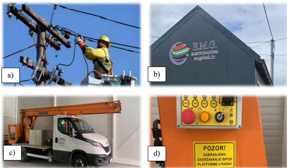
Slika 2. a) električar koji se nalazi u autokošari, b) E.M.G. radiona, c) promatrana autokošara parkirana u garažnoj prostoriji, d) znak upozorenja na samoj autokošari [2]
