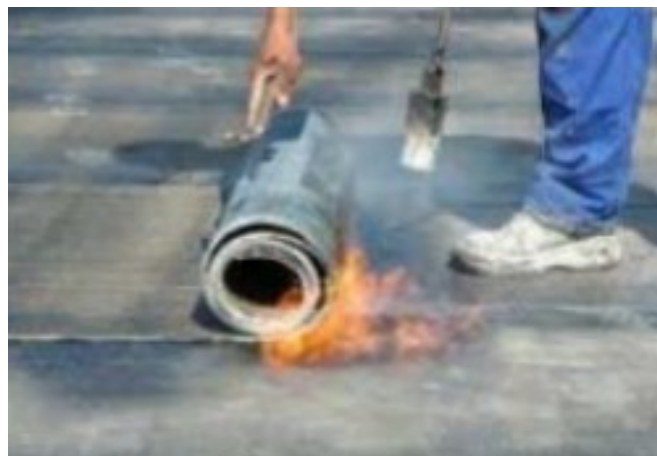
Slika 18. Postupak bitumeniziranja lijepljenjem [28]
