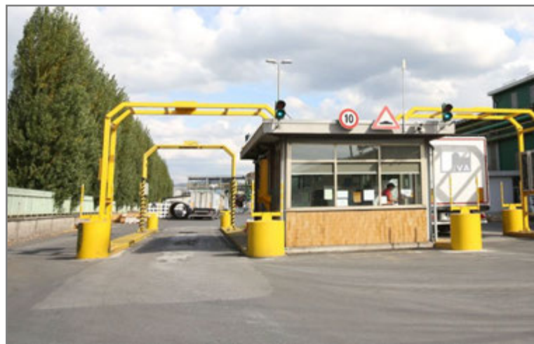
Slika 2. Primjer instaliranog stacionarnog sustava/portala na ulazu u proizvodni pogon gdje se obrađuje čelični otpad [37]
