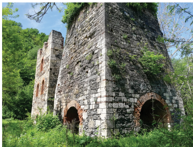
Visoke peći Bešlinec
