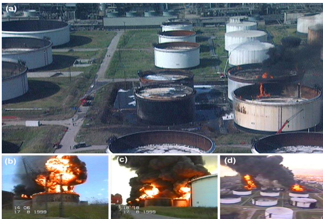
Slika 2. Požar spremnika za naftu rafinerije u Izmiru [6]
