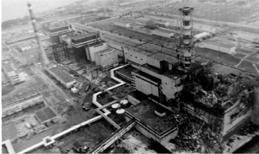
Slika 5. Uništena zgrada reaktora bloka 4 u nuklearnoj elektrani Černobil [18]
