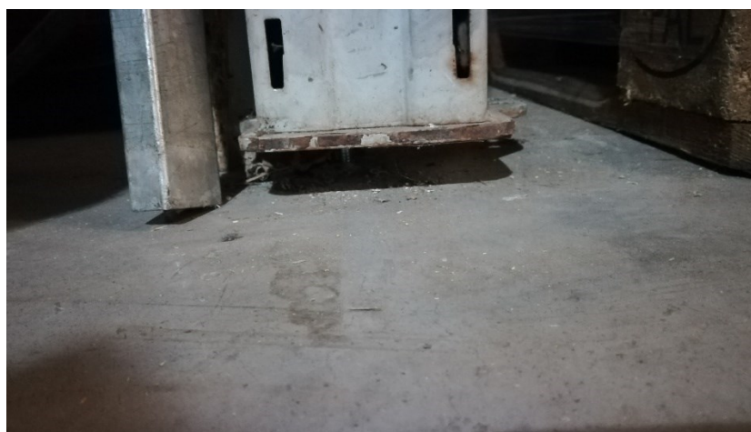
Slika 11. Učvršćenje podne ploče [4]
