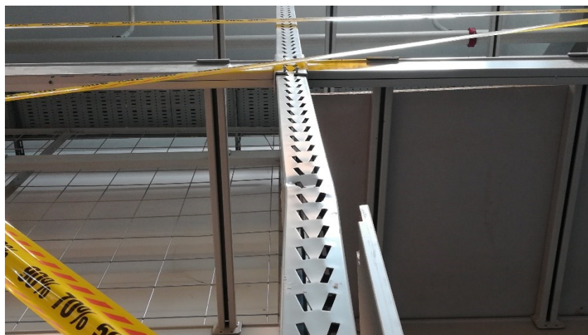
Slika 10. Izvijanje profila sprijeda [4]
