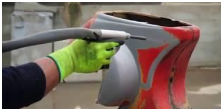
Slika 17. Uklanjanje nečistoća mlazom abraziva [26]
