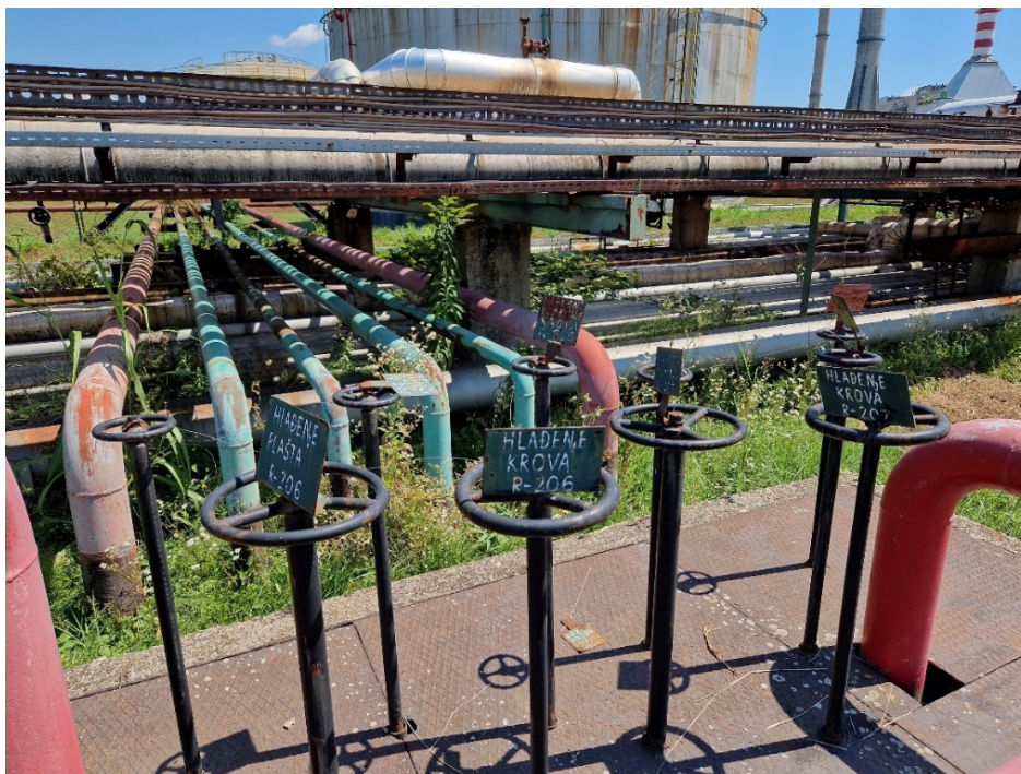
Slika 10. Prikaz ručnog uključivanja hlađenja spremnika
