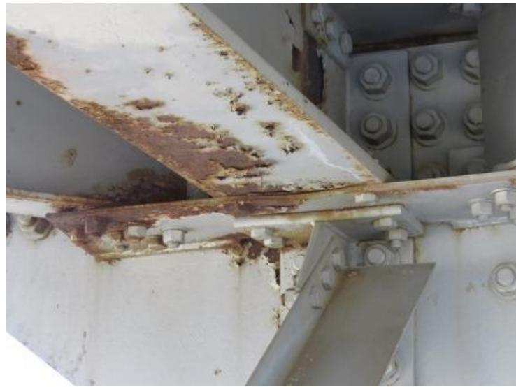
Slika 8. Primjer pjegaste korozije, spoj na mostu [16]
