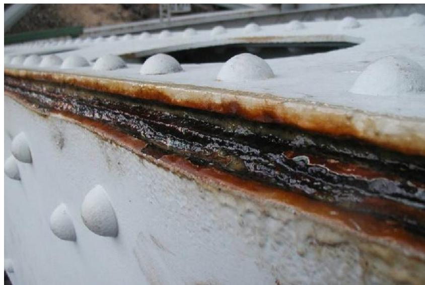
Slika 12. Primjer korozije u procjepu, spoj na konstrukciji [19]
