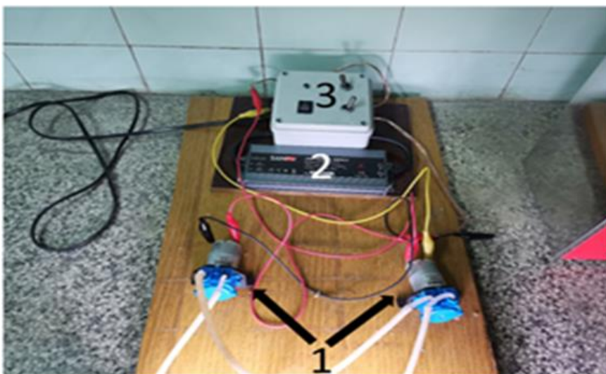
Slika 13. Prikaz dijelova fotoreaktora, 1. Peristaltičke pumpe, 2. Transformator, 3. Sklopka
