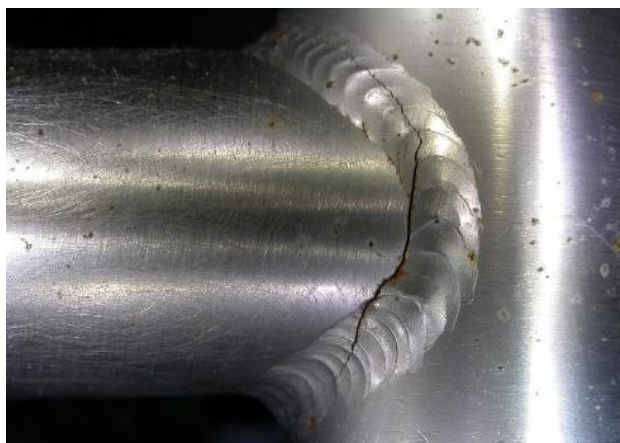
Slika 5. Pukotina zavarenog spoja [19]
