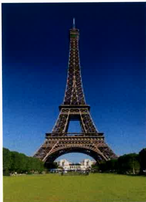
Slika 17. Zaštita Eiffelova tornja od korozije pomoću zaštitnih prevlaka [14]
