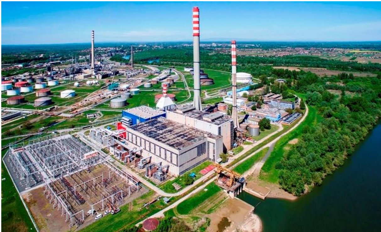
Slika 10. Prikaz termoelektrane i rafinerije Sisak [13]
