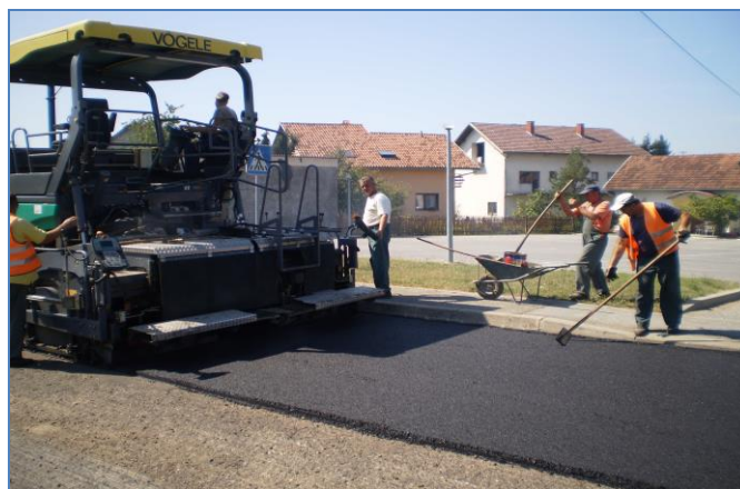
Slika 19. Nanošenje asfalta izrađenog s agregatom od elektropečne troske [69].
