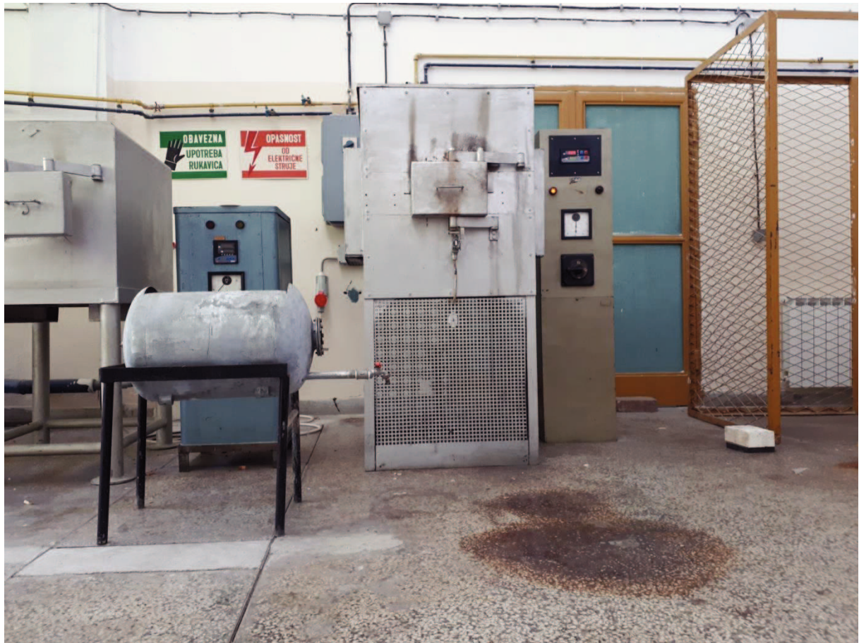
Slika 32. Fotografija elektrootporne komorne peći za žarenje
