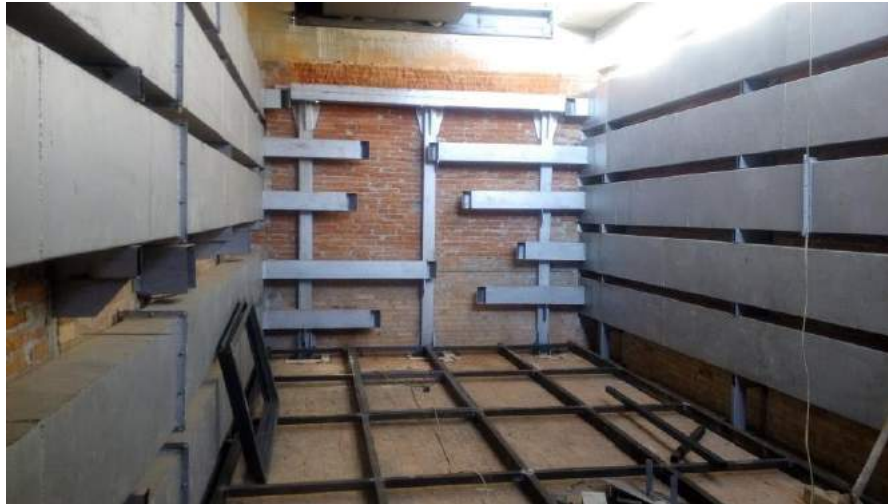
Slika 4. Unutrašnji izgled sušare
