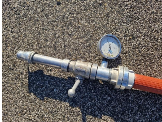
Slika 47. Provjera tlaka tijekom ispitivanja
