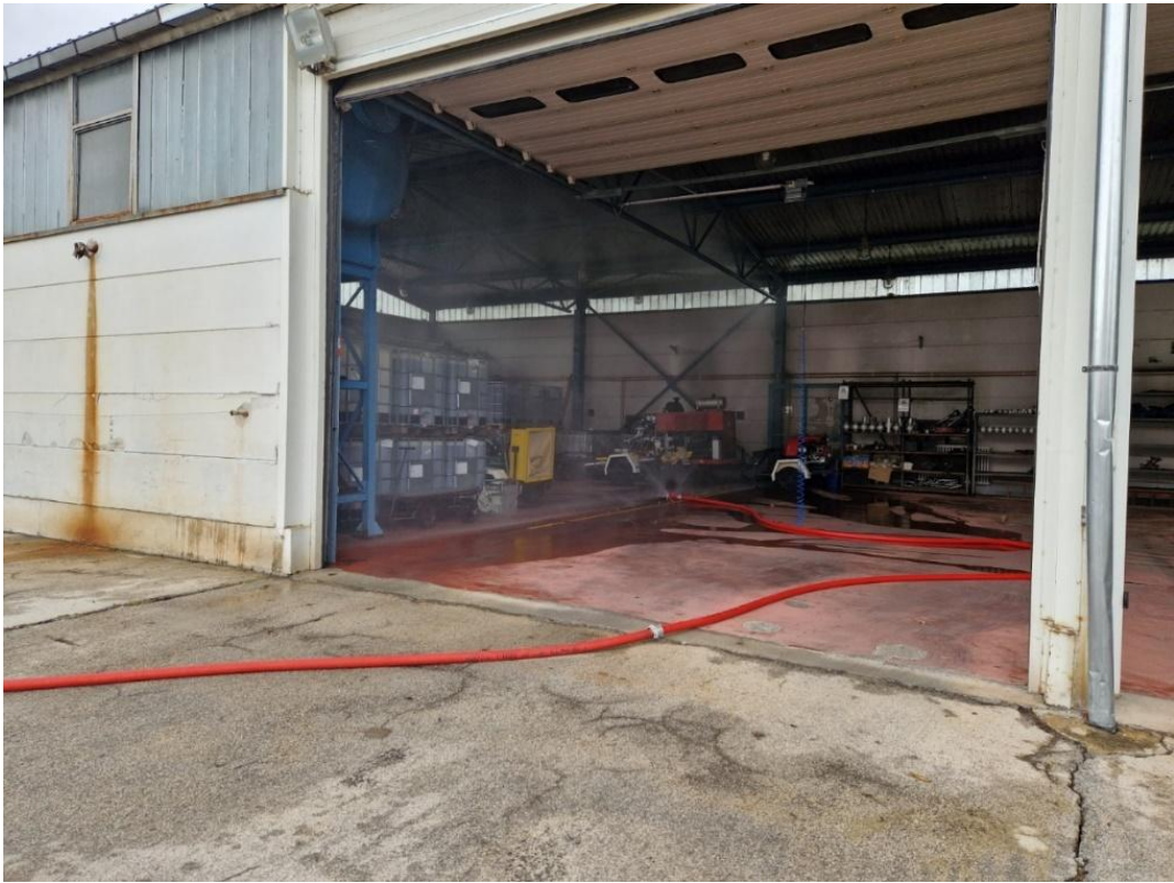
Slika 34. Vodeni štit za sprječavanje širenja požara na ostatak garaže
