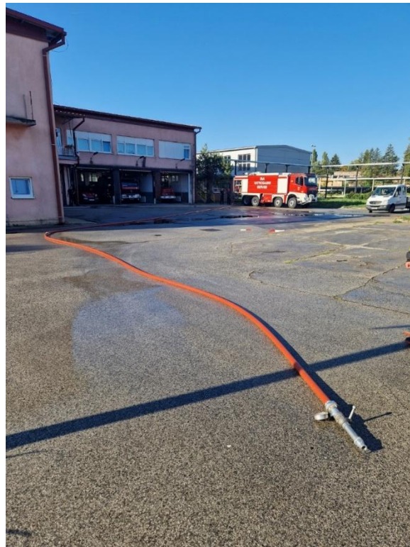
Slika 46. Postavljanje ispitne cijevne pruge
