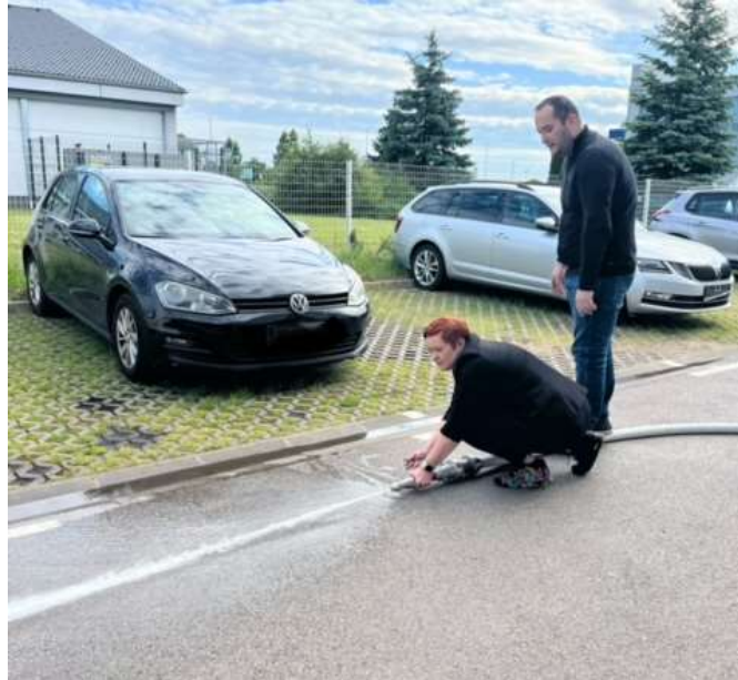
Slika 17. Ispitivanje ispravnosti unutarnje hidrantske mreže
