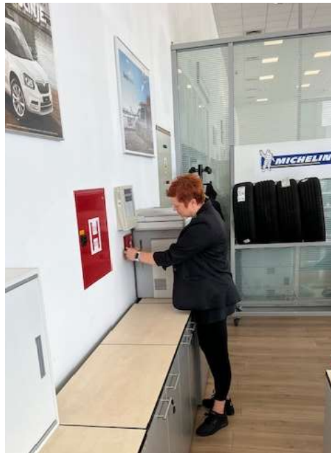
Slika 33. Ispitivanje ručnog javljača
