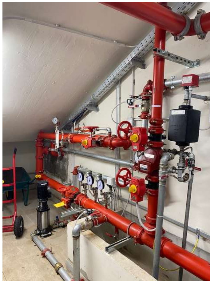
Slika 14. Sprinkler stanica
