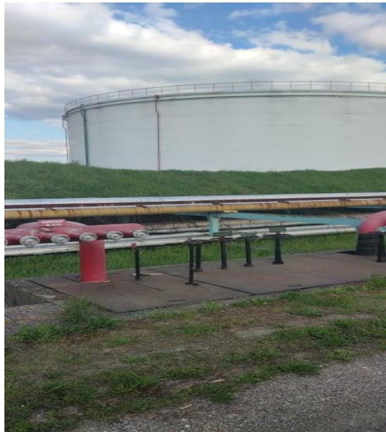
*Slika 6. Sustav za hlađenje raspršenom vodom na spremniku*
