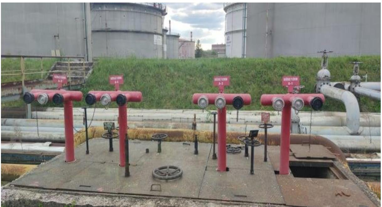
Slika 8. Polustabilni sustavi za gašenje požara zračnom pjenom
