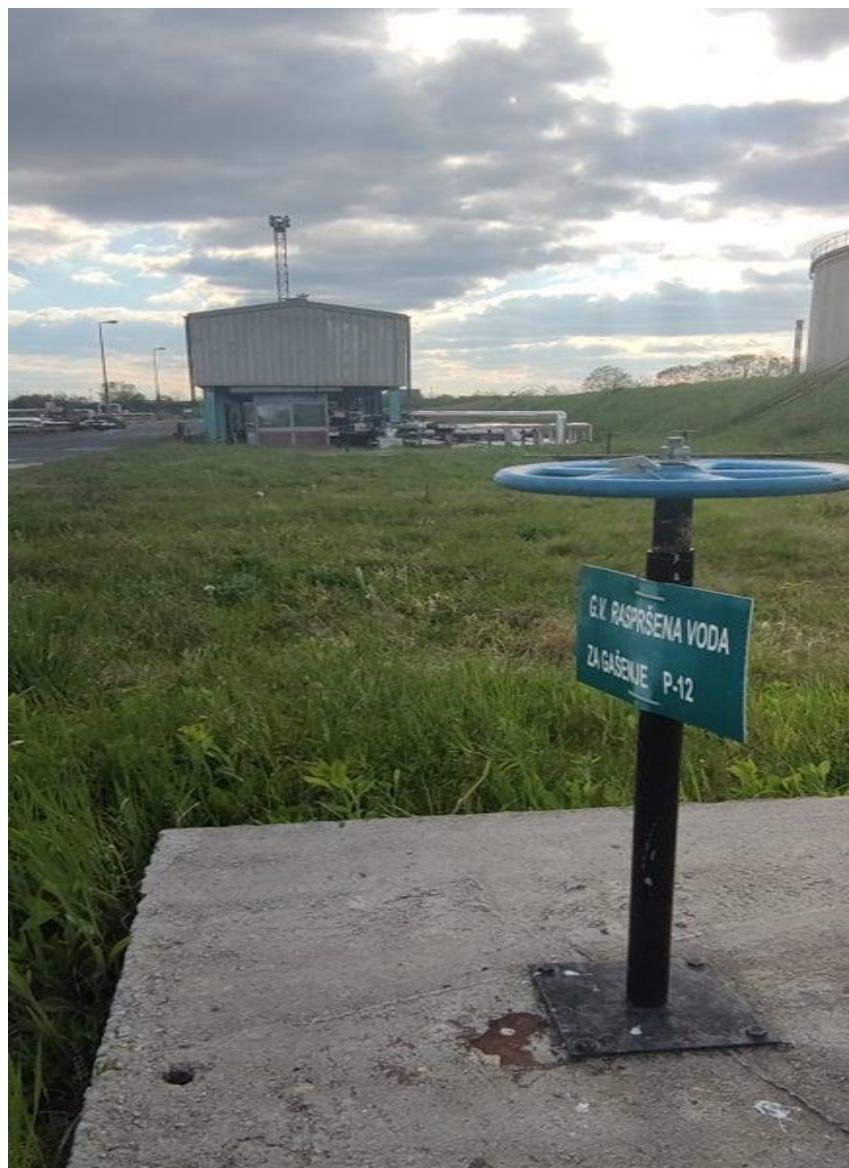
Slika 7. Sustav za hlađenje raspršenom vodom za pumpanu
