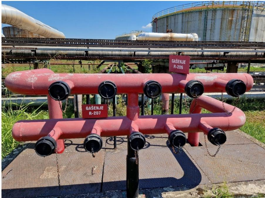
Slika 14. Priključci polu-stabilnog sustava u RNS
