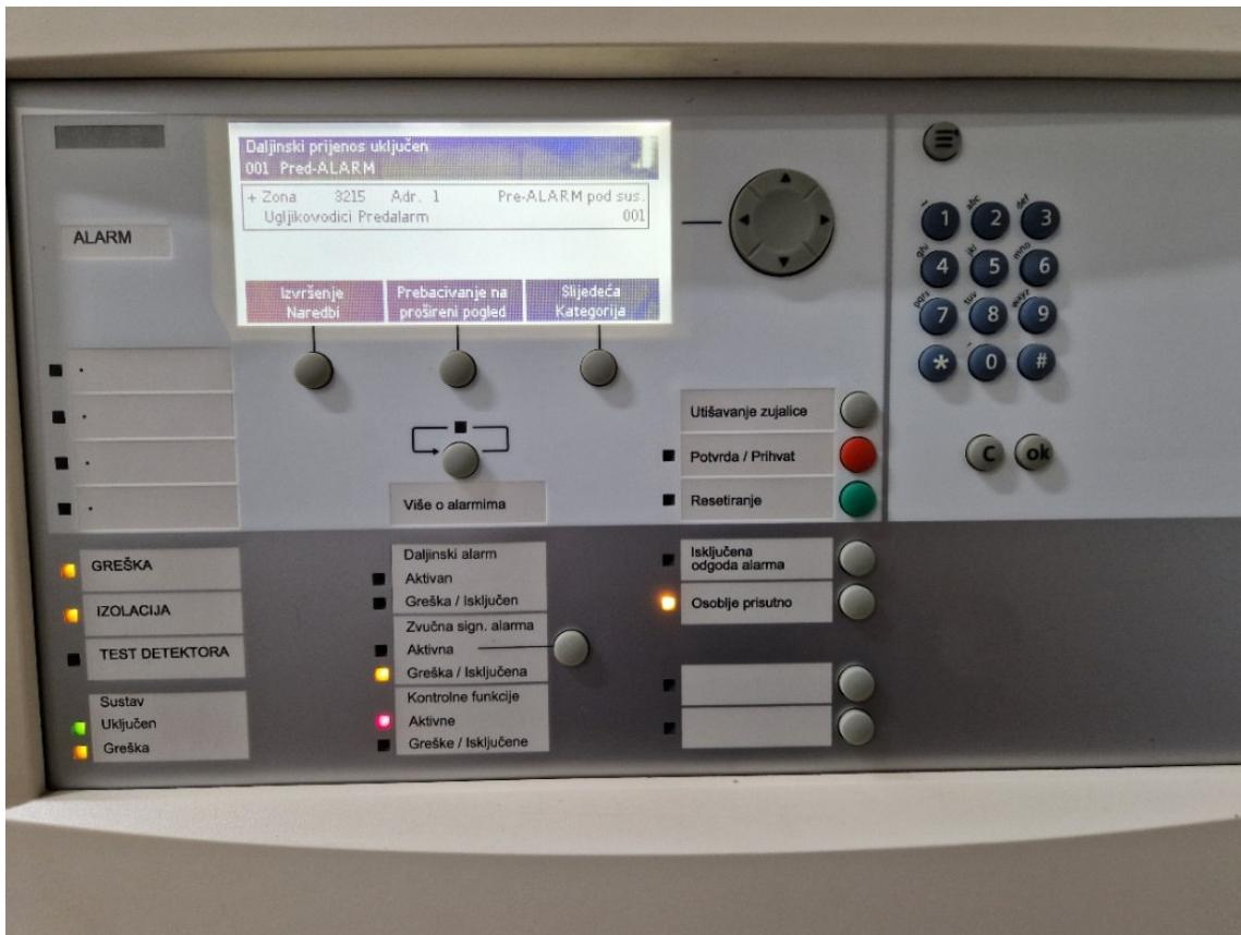
Slika 7. Digitalna nadogradnja javljača požara sa sustavima pre-alarma
