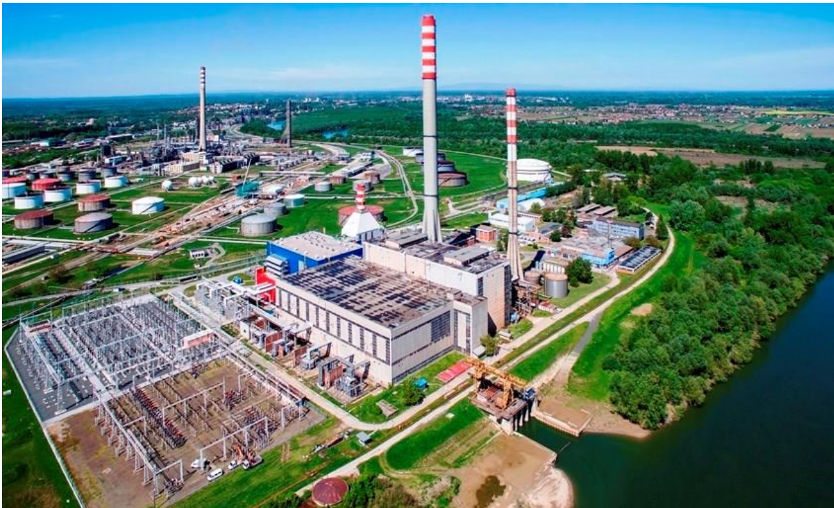
Slika 10. Prikaz termoelektrane i rafinerije Sisak [13]
