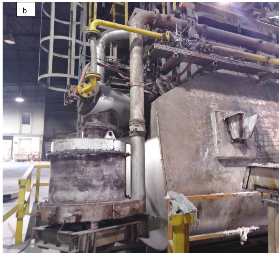
Slika 35. a) Sklopnji crtež regenerativnog gorionika na peći za držanje taline b) regenerativni gorionik u CIAL d.o.o.
