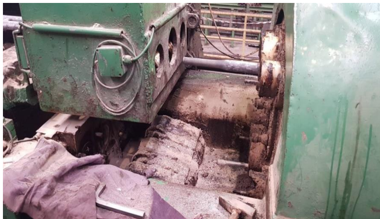
Slika 21. Uvlačenje cijevi u bubanj
