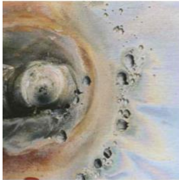
Slika 9. Posljedica rupičaste korozije [11]
